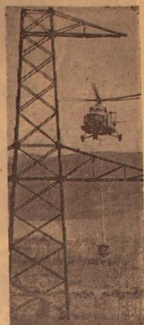
SACHALIN. Die Testflieger des Unions-Forschungsinstituts der Zivilflotte für Landwirtschaftliche und Sonderaufträge arbeiten an der Errichtung der Masten für die Hochspannungsleitung und montieren diese Leitungen mit Hilfe des Hubschraubers Mi-8. Diese Methode soll bei Bauarbeiten auf dem Wald- und Mooregelände sowie im Gebirge weitgehend angewandt werden. Dort, wo die Menschen mehrere Tage arbeiten müßten, benötigt der Luftmontagearbeiter dazu wenige Stunden.
