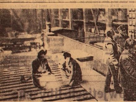
Im Alma-Ataer Hausbaukombinat wird die Rekonstruktion der Hallen durchgeführt. Es werden neue Kapazitäten im Betrieb geschaffen, neue Aggregate montiert und moderne technologische Methoden erschlossen. Alle diese Neuaufbauten finden ohne Unterbrechung des Hauptprozesses statt. Nach der Rekonstruktion aller Hallen wird sich
