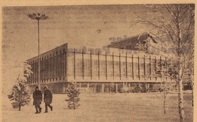
ZELINOGRAD. Unlängst haben die Bauleute des den Leninorden tragenden Trusts „Zelintrastroi“ ein einmaliges Gebäude — den Palast der Jugend seiner Bestimmung mit der Note „ausgezeichnet“ übergeben. Dieses hübsche Haus aus Stahl, Beton und Glas hat einen Zuschauerraum mit 1200 Plätzen, einen Sportsaal mit Tribünen für 400 Zuschauer, ein Schwimmbecken, eine Bibliothek für 500 000 Bände, ein Kunststudio, Zimmer für Zirkelarbeit und Sportsektionen.
