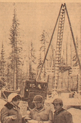
REGION KRASNOJARSK. Das Wasserkraftwerk Bogutschansk wird die vierte Kaskade an der Angara sein nach Irkutsk, Bratsk und Ust-Ilim. Die Mitarbeiter der Bogutschansk Expedition des Instituts „Sibirgiprojekt“ wählten den Ort der künftigen Sperrstelle unweit von Kodinskje. Kurz vor Neujahr haben die Geologen die erste Bohranlage auf dem Eis der Angara aufgestellt. Die Bauleute der Kraftverkehrsstraße, die den Bauplatz des Wasserkraftwerks Bogutschansk mit der Ortschaft Sedanowo verbinden soll und durch die die Straße Bratsk — Ust-Ilim führt, sind in die Taiga gekommen. UNSER BILD: Von links die Technikerin-Geografin der Expedition L. M. Smirnowa, der Schriftführer G. S. Fjodorow, sein Gehilfe N. I. Kulikow an der künftigen Sperrstelle. Foto: TASS
