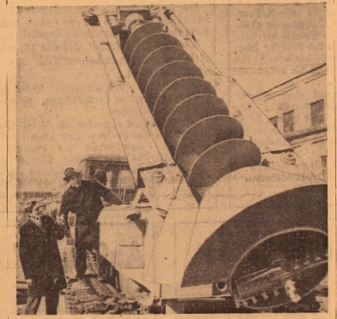
IWANOWO. Das Mechanische Werk „Glawenergostromechanizacija“ begann mit der Serientilgung der Maschinen „ARK-750 T“...
