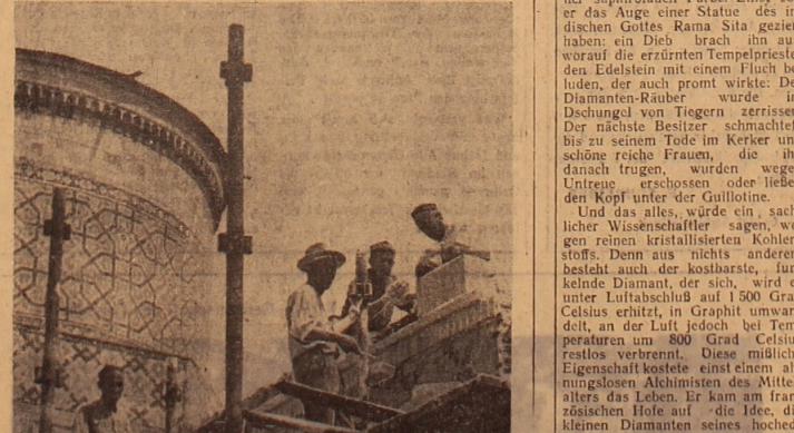
UNSER BILD: Restauration einer Medresse in Samarkand.
