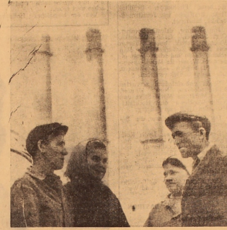
Die Ausmauerungsbrigade der Rüstungshalle, die von dem Bestarbeiter Jakob Eichhorn geleitet wird...
