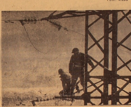
UNSER BILD: In den Bergen Kirgislands wird die Stromleitung montiert. Die Länge dieser Linie wächst ständig und beträgt zur Zeit 32 000 Kilometer. Foto: TASS
