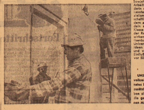
Claus FRIEDRICH, (Panorama/DDR) UNSER BILD: Die Arbeiter des volkseigenen Wohnungsbaukombinates bauen in der DDR-Hauptstadt zusätzlich 208 Wohnungen und haben sich vorgenommen, gleichzeitig die geplanten Kosten um 7 Millionen Mark zu unterbieten.
