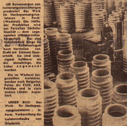
UNSER BILD: Das Werk für Hochspannungsisolatoren in Perm. Vorbereitung der Isolatorneube zu Glasieren. Foto: APN
