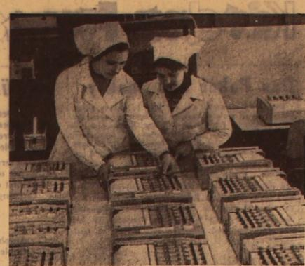
Das Krasnojarsker Werk für elektrische Meßgeräte begann mit der Serienproduktion eines neuen registrierenden Meßgeräts. Dieses Gerät ist für die Registrierung von schnellverlaufenden Prozessen in Diapason von 0 bis 100 Hertz bestimmt. Die Geschwindigkeit des Diagrammbands kann im Ausmaß von bis zu 250 Millimeter je Sekunde geändert werden. Die augenblickliche Wahl einer beliebigen der 8 Geschwindigkeiten ist möglich.
