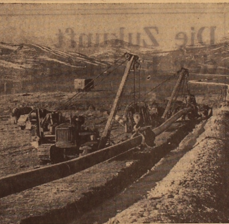
UNSER BILD: Am Bau der Gasleitung Schwamschal-Bulak — Mächatsch-Kala. Foto: R. Dyck (TASS)
