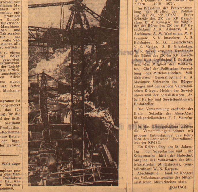
Das Toktoguler Kraftwerk im Bau. Foto: TASS
