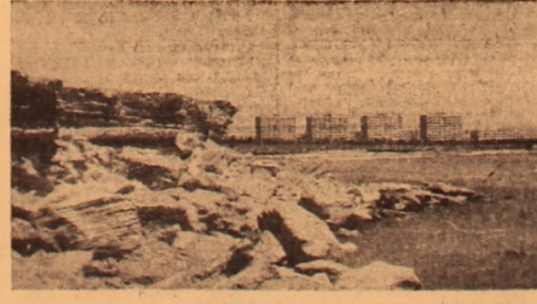
Auf der Halbinsel Mangyschlak wächst die Großstadt Schewitschenko empor. Der Generalplan für ihre Bebauung wurde schon 1964 erarbeitet, zur Zeit ist sie eine schöne Küstenstadt. Foto: I. Iwanow (TASS)
