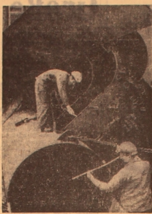
DDR. In der Matthias-Thesen-Werft wird ein neues Schiff gebaut. Der Passagierliner wird die Meere unter der Flagge der DDR durchfahren. In zwei Jahrzehnten wurden von der Schiffbauindustrie der Republik an die Bessler aus mehr als 20 Ländern der Welt über 3.000 Schiffe übergeben.
