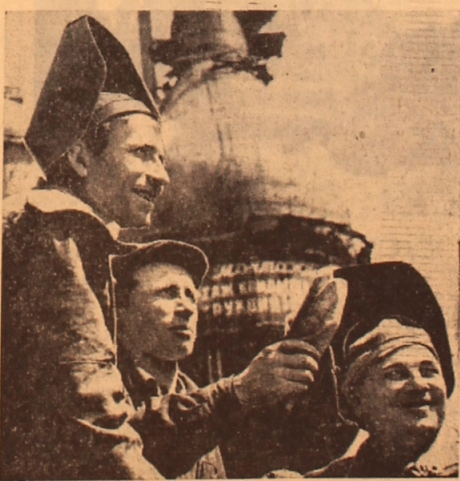
Im Karagandaer Hüttenwerk wird der dritte Hochofen, das für 1970 zur Inbetriebnahme geplante Objekt, im Stofftempo gebaut. Mit seiner Inbetriebnahme wird die Roheisenproduktion sich verdoppeln.
