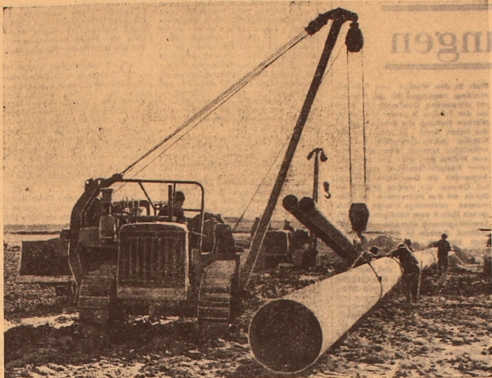
Vor kurzem wurde der Bau der 350 Kilometer langen Gasleitung Duschambe—Jawan begonnen. Durch diese Leitung soll schon in diesem Jahr der Naturbrennstoff für das im Januar Tal errichtete Wärmekraftwerk und für ein mächtiges elektrochemisches Kombinat kommen.
