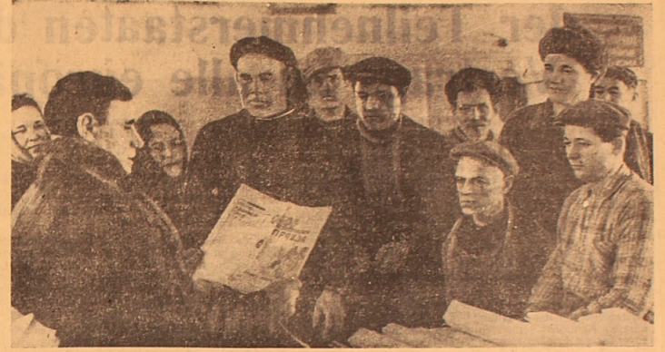
Vor Arbeitsbeginn. Viele Mitglieder der Brigade der kommunistischen Arbeit des Zellinger Bauabschnitts des Baufrüsts der Kasachischen Eisenbahn (Brigadier Johann Wagner) sind schon am Arbeitsplatz und Meister Timofej Schuschpanow liest die letzten Meldungen über die Provokationen an der sowjetisch-chinesischen Grenze vor.
