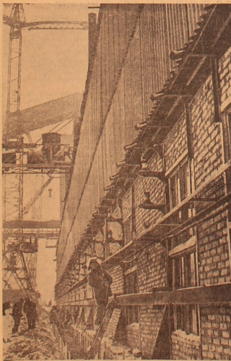
In der Kasachstaner Magnitka geht der Bau der fünften Koksbatteie zu Ende. Die Bauarbeiter wetten darum, daß die Batterie im neuen Jahr in Betrieb genommen wird. UNSER BILD: Der Bau der fünften Koksbatteie im Karagandaer Hüttenwerk. Foto: J. Turin (KasTAg)
