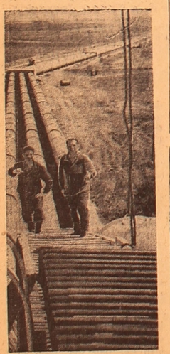
JEREWAN. Die Belegschaften der vier Bauverwaltungen des Trusts „Armedrot“ und der Rosdner speziellen Verwaltung des Trusts „Armpromtash“ haben zwei Jahre vor dem festgesetzten Termin die Montagearbeiten der größten Mechtchansker Pumpstation der Republik beendet. Mit ihrer Inbetriebnahme werden 130 Millionen Kubikmeter des Sewansker Wassers eingeparkt. Tausende Hektar Land des Ararat-Tals bewässert. Der lebenspendende Naß fließt auf die Felder. UNSER BILD: Ein Abschnitt der Wasserleitung Foto: B. Nemrut (TASS)
