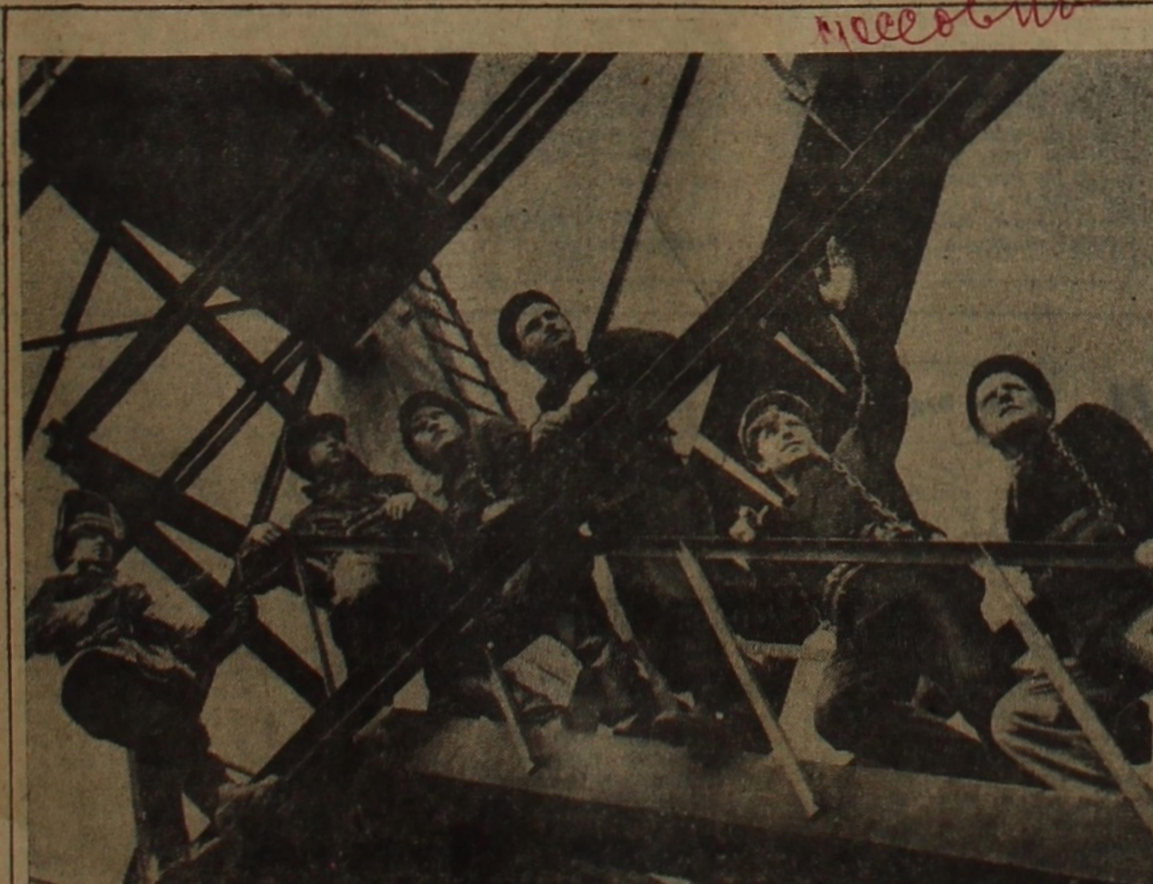
Diese Hochmontagearbeiter aus der Brigade von Philipp Selwert gehören zu den Kühnen im Trust „Kastalokonstruksija“. Sicher und gut arbeiten sie hoch im Blauen an den Bauten des Aluminiumwerks von Pawlodar. Ihr Tagessoll erfüllen sie von 150 bis 180 Prozent. UNSER BILD: (von rechts) Die Hochmontagearbeiter Nikolai Borot, Leonid Siwak, Viktor Schubalov, Wladimir Dronow, Valeri Dawydow und Konstantin Knaub. Foto: D. Neuwirt
