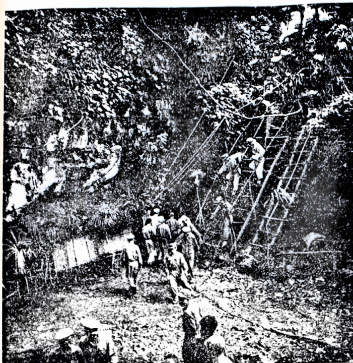
Höhlen, die mehrere Rayons von Laos buchstäblich durchqueren, und durch die patriotische Front kontrolliert werden, sind unter den Verhältnissen der ununterbrochenen feindlichen Bombardierungen zu natürlichen Luftschutzkellern geworden. Hier leben, lernen und arbeiten ganze Militäreinheiten. Das gut organisierte Beobachtungs-, Warn- und Nachrichtensystem hilft den Kämpfern der patriotischen Streitkräfte, im Notfall ihre Kampfpозиtionen rechtzeitig zu beziehen.
