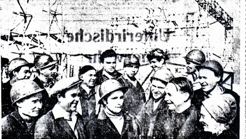
Gebiet Donerk. In der Slawjansk-Wärmezentrale wurde die Montage des größten Elektroblocks in Europa mit einer Kapazität von 800.000 Kilowatt vollendet. Das Gas dieses Blases wurde angezündet und der Kessel angeheizt. Diese unikale Anlage wird 2.500 Tonnen Dampf mit einem Druck von 255 Atmosphären und einer Temperatur von 585 Grad erzeugen, der in einen zweiwalzigen Generator geleitet wird. UNSER BILD: Bestarbeiter der Abteilung „Jusbelek-tromonash“. Foto: S. Gendelman (TASS)
