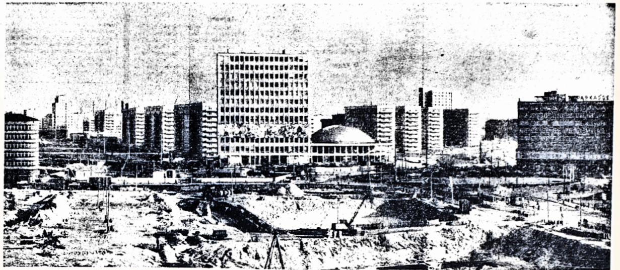
GRÖSSTE BAUSTELLE DER HAUPTSTADT BERLIN
