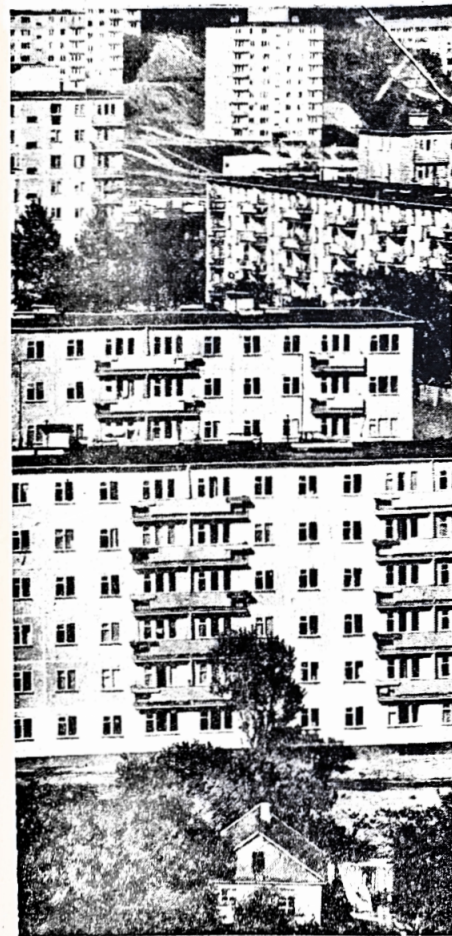
Einer der neuen Mikrorayons an der Wloraia Betschka
