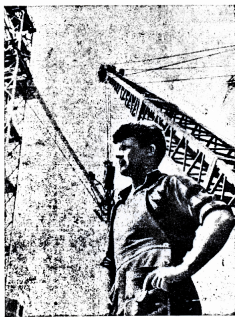
Der beste Baggerführer Michail Primak, der am Bau des Tiraspoler Wasserkraftwerkes, Gebiet Kiew, beschäftigt ist, erfüllt sein Schichtsohl zu 140 — 150 Prozent.
