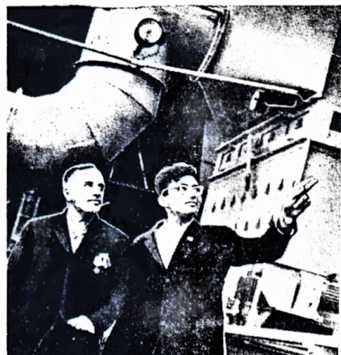
Bauleiter der Saatgut-aufbereitungsanlage Friedrich Zitzer und Ingenieur des Bauvorhabens Schewket Karabal besichtigen die Anlage.
