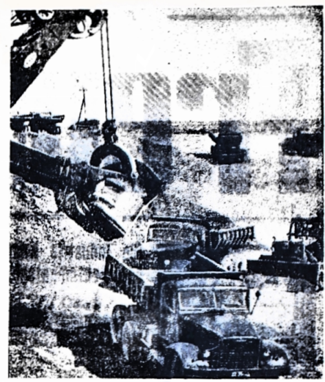
Diese ganze System wird den Steppenfluß in Richtung Karaganda lenken. Am Kanal trifft immer neue Technik ein. Für das Bauvorhaben sind zusätzlich drei 5-Kubikmeter-Schreibbagger, 17 3-Kubikmeter-Raupenbagger, viele Traktoren, Bulldozer, Schrapper, Lastwagen bestimmt.
