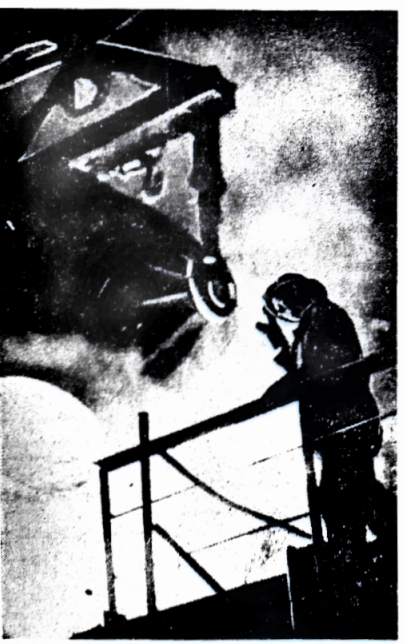
Im Westen der Kolahabinsel, an der Grenze mit Norwegen befindet sich die Stadt Nickel. Die Kapazität des hier in den Nachkriegsjahren errichteten Kombinars „Petschenganiel“ steigt von Jahr zu Jahr. Neue Nickelvorkommen werden erfolgreich erschlossen, der Betrieb wird ständig erweitert und rekonstruiert. Die Belegschaft des Kombinars hat sich verpflichtet, im Jubiläumsjahr für 600.000 Rubel Erzeugnisse über den Plan hinaus zu liefern. UNSER BILD: In der Schmelzhalle des Kombinars „Petschenganiel“ (Gebiet Murmansk). Foto: W. Perwenzew (APN)
