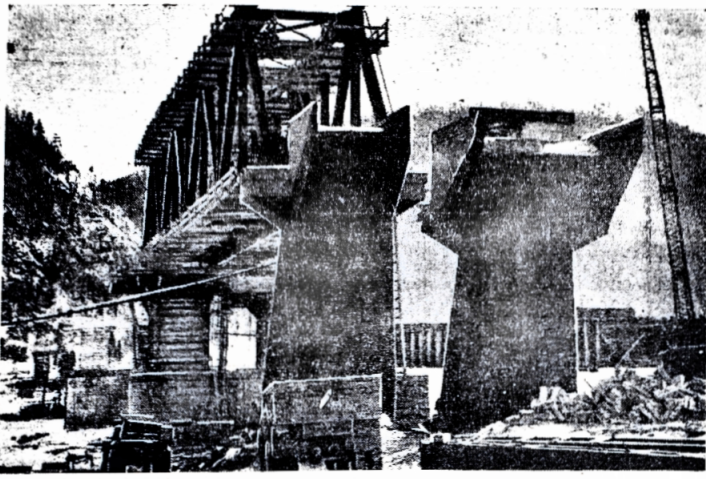
Das Wasserkraftwerk in Sajano-Schuschensk ist die größte Elektrizitätszentrale, die auf unserem Planeten gebaut wird.
