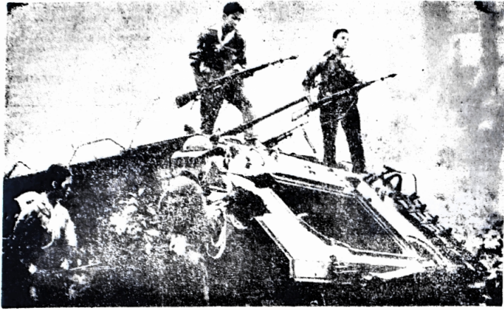
Südvietnam. Die Soldaten der Befreiungsarmee an einem beschädigten, bewegungsunfähigen amerikanischen Schützenpanzerwagen. Foto: TASS.
