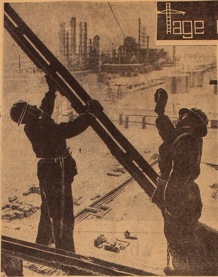
JAROSLAWL Mit Vollampf geht die Errichtung der größten katalytischen Krackanlage im Nowo-Jaroslavl Erdölverarbeitungs- und Erdgaswerk. Es ist die größte Anlage des Betriebs. Ihre Höhe erreicht 72 Meter. Das Kollektiv der Bauarbeiter hat beschlossen, diese Anlage bis Ende Dezember fertigzustellen. Im neuen Jahr beginnt die katalytische Krackanlage die Benzinkproduktion höchster Qualität zu liefern.
