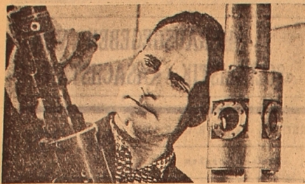
Die Mitarbeiter der Aktjubinski Filiale des Instituts für Geologie und Geophysik haben erstmalig in unserem Land ein Fotogerät konstruiert und gefertigt, mittels dessen die Wände der Bohrlöcher auf Erdöl und Gas fotografiert werden können.
