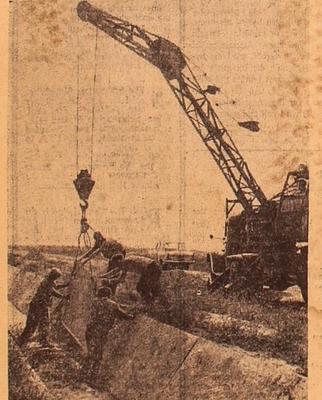
Zwei Pumpstationen, ein Wassersammelbecken mit einem Fassungsvermögen von 15 tausend Kubikmeter sowie Abzugskanäle mit der Gesamtlänge von 4 Kilometern werden im Kolchos „Sapowit Lenina“, Rayon Wassiljewa, Gebiet Sapowirje errichtet. UNSER BILD: Die Verbindung eines Abzugskanals mit Stahlbetonpfeilern im Kolchos „Sapowit Lenina“.
