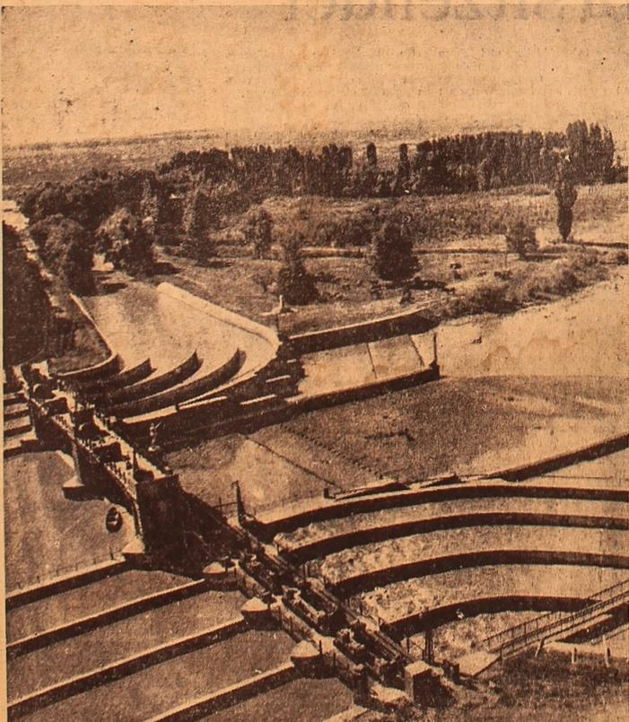
GBIET DSHAMBUL. Der Tschu-Staudamm unweit des Dorfes Georgijewka. Er dämmt den Fluß Tschu ab. Von hier fließen die Wasser des Flusses in zwei Kanäle. Der eine versorgt die Kolchos- und Sowchosfelder Kasachstans, der andere die Kirgisien mit Wasser. Foto: W. Posdenko
