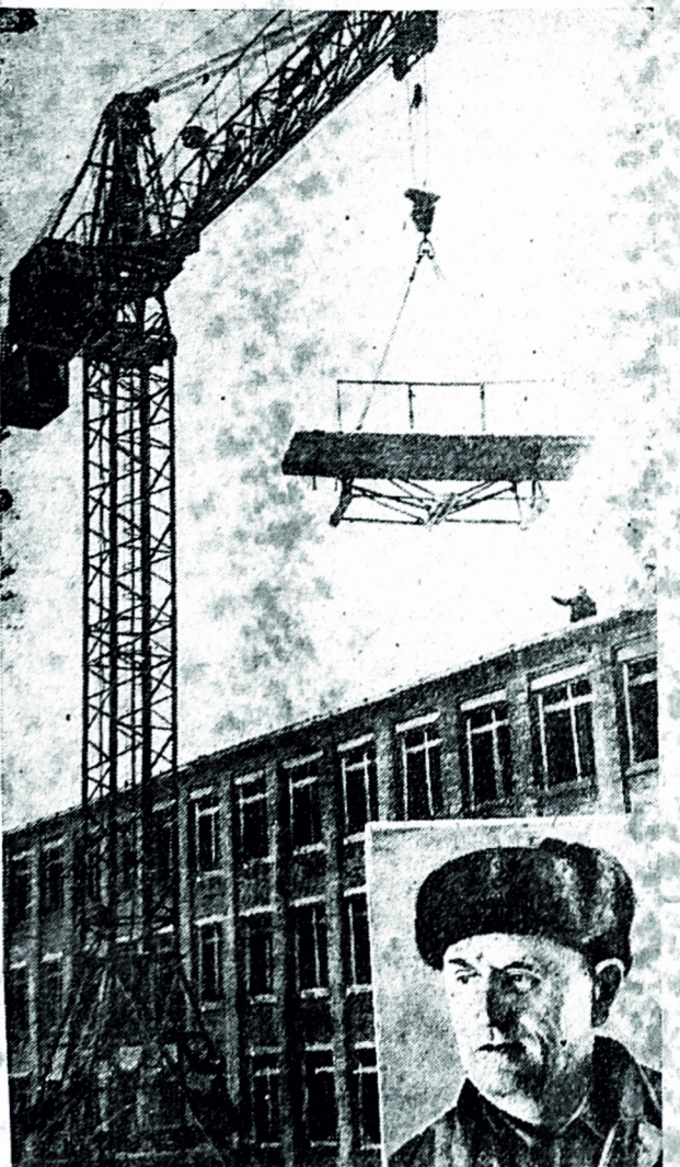
Schon 20 Jahre leitet der Kommunist Heinrich Born eine Komplexbrigade des Wohnbaustruts in Ust-Kamenogorsk. Die Brigade arbeitet gegenwärtig an einer Schule für 960 Schüler. Um die Schule vorfristig fertigzustellen, wird dort jede Arbeitsminute voll ausgenutzt. Die Brigade hat sich verpflichtet, ihr Tagessoll zu 150 Prozent zu erfüllen und kommt dieser Verpflichtung erfolgreich nach. UNSER BILD: Der Brigadier der Komplexbrigade Heinrich Born. Foto D. Neuwirt.
