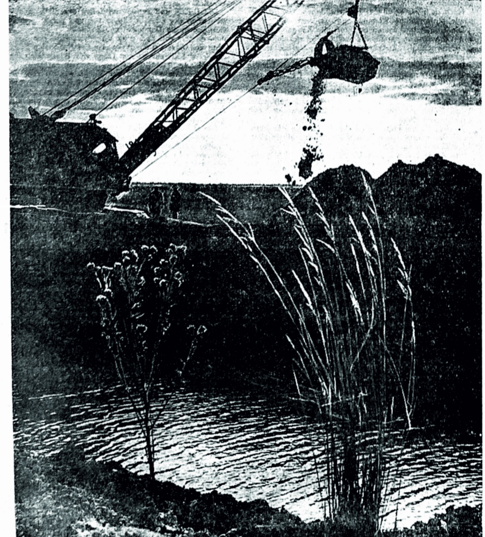
UNSER BILD: Der Bau des Tsumrun-Kanals geht immer weiter.
